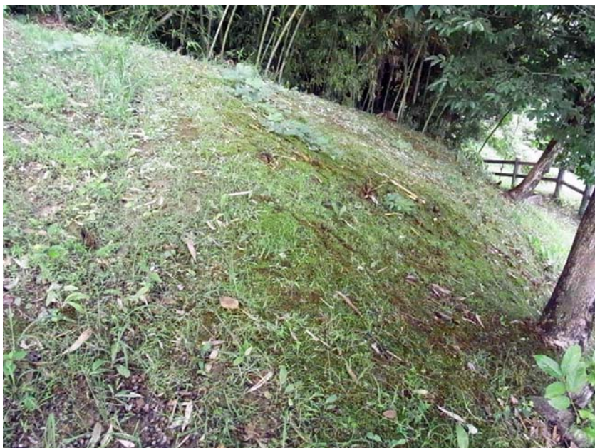
④-2 ④-1 の下位のり面で、 雨水による植生流失 が発生している。この まま放置すると、土砂 流失に繋がる。
