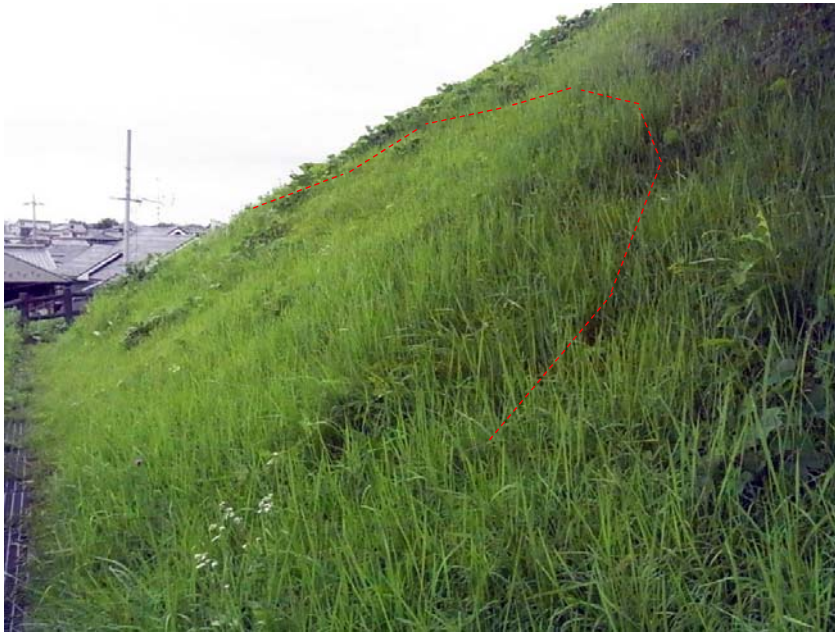
③ 滑落崖から北側のり 面にかけて、薄く、表 層侵食或いは崩壊後 が見られる。
